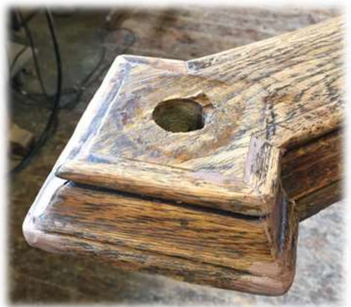
Kittung der abgeschlagenen Ecken
