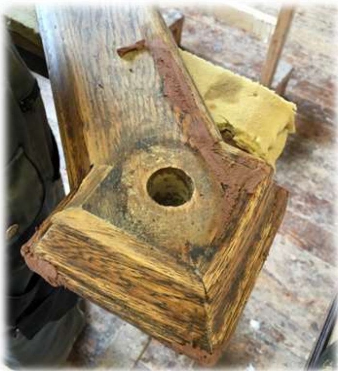
Kittung der abgeschlagenen Ecken
